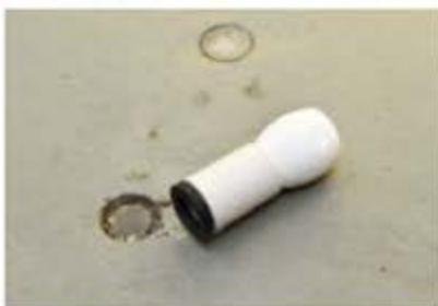
リフトをしっかり支えるのは10cmほど施工時に埋め込んだセラミック製の支柱。この支柱にアンカーでリフトを固定して使用する。リフトの支柱がないことで普段はフロアスペースをフルに有効活用。
