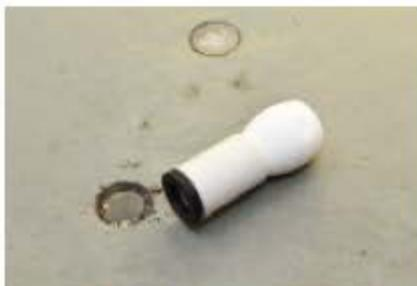
リフトをしっかり支えるのは10cmほど施工時に埋め込んだセラミック製のアンカー。このアンカーにリフト支柱を固定して使用する。リフトの支柱がないことで普段はフロアスペースをフルに有効活用。
